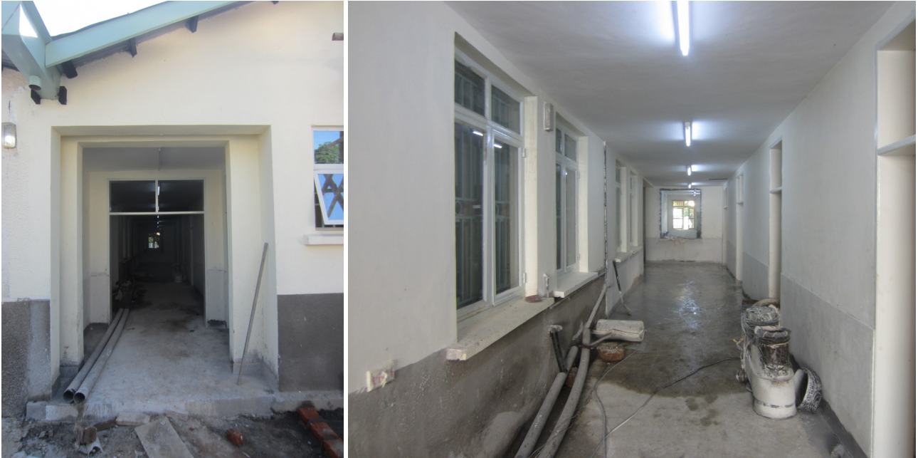
De vernieuwing binnen het gebouw
