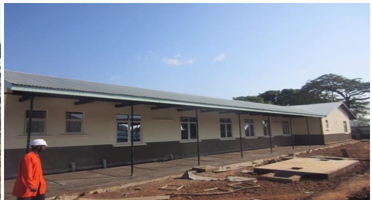
De buitenkant afgewerkt
