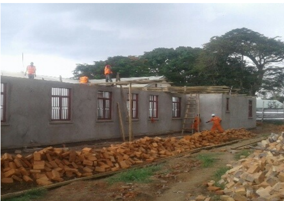
Het dak en de veranda in wording
